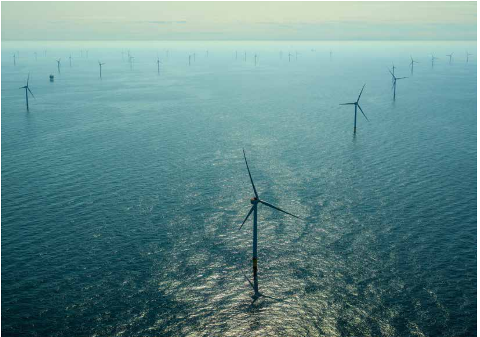
Ganze Wirtschaftszweige leben vom Umbau des Energiesystems: niederländischer Offshore-Windpark in der Nordsee.
